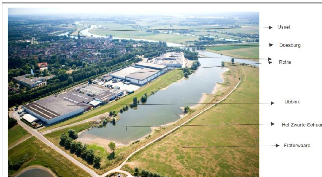
Figuur 1.1 Overzicht van de bestaande locatie aan de Verhuellweg (Bron: NRD)
