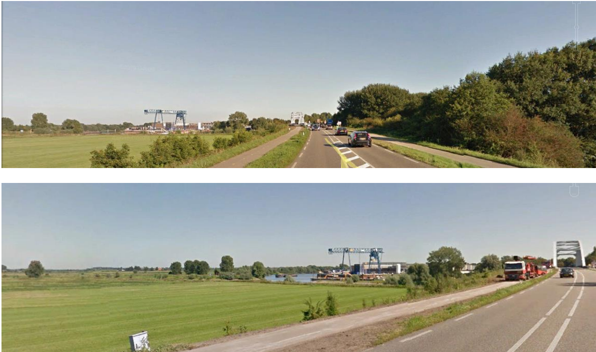
Figuur 2.5 Beeld van de westelijke entree van Doesburg met de bedrijvigheid aan de Verhuellweg
